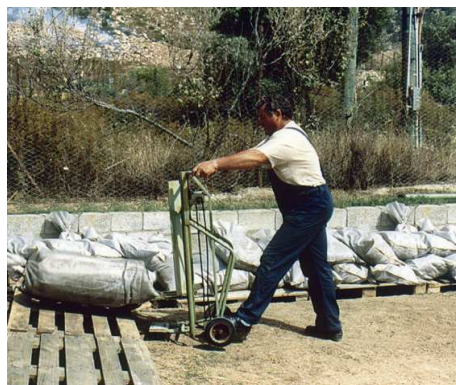
Układanie worków na placu składowym
